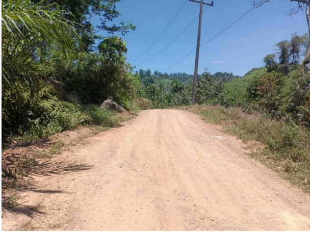
ภาพก่อนดำเนินการ
