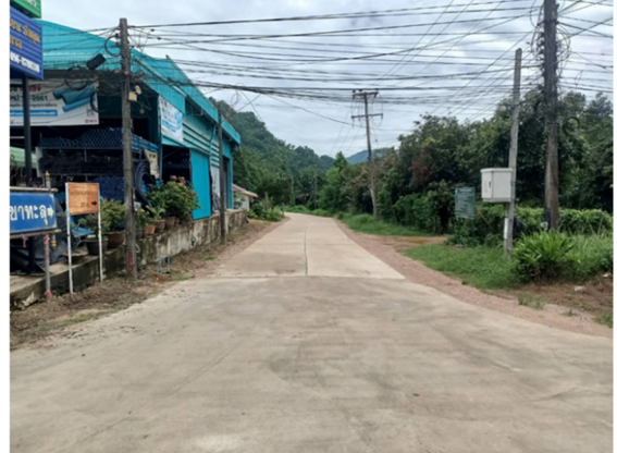
- ภาพหลังดำเนินการ -
